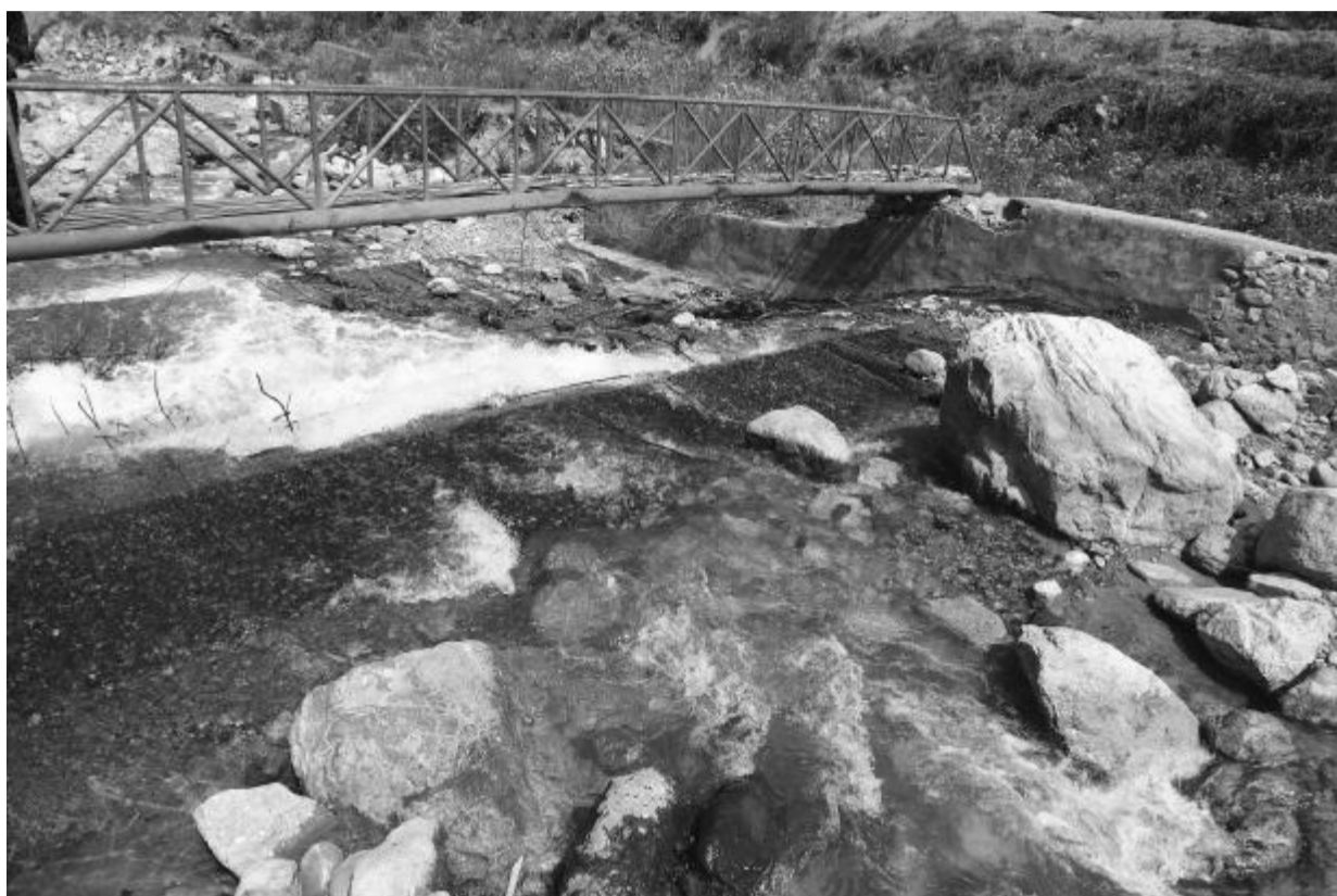
五级电站拦水坝已经被砂石填满
