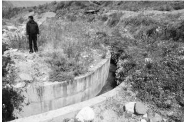
已建成的五级电站引水渠道
