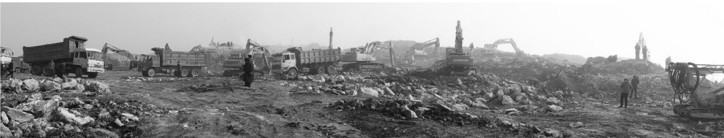
车辐山镇废旧矿山复垦工程现场
