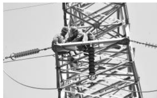
工作人员在铁塔上安装防鸟害装置
