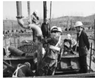
钟选良经理现场察看高墩砼浇筑
