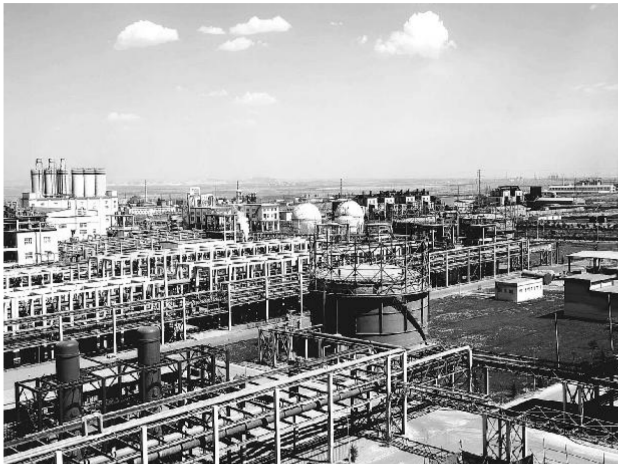
中盐吉林泰氨酸化工生产厂区俯瞰
