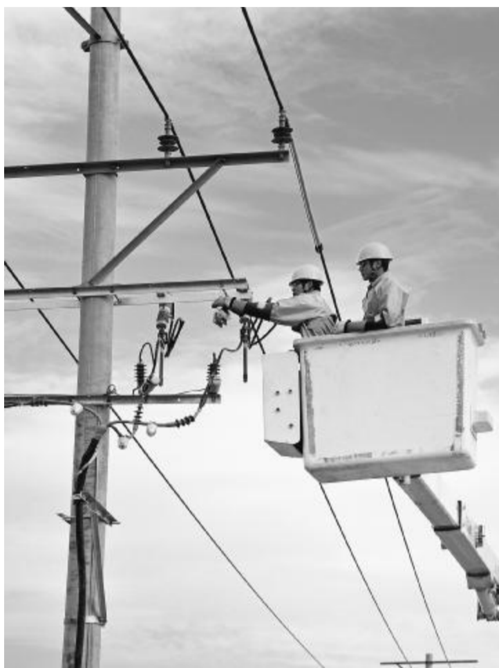
开展带电作业，避免停电影响。叶晓峰/摄
