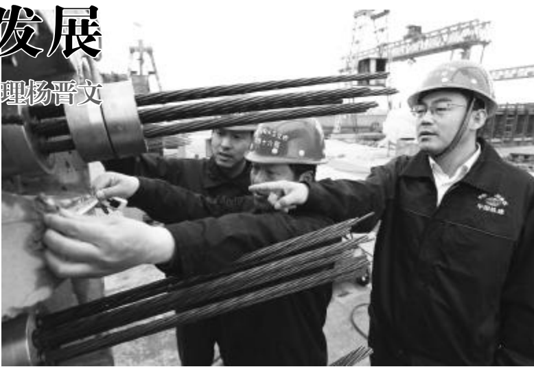
五公司副总经理兼项目经理杨晋文在现场指导预制梁预应力束张拉
