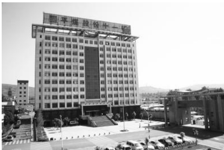
十一矿综合办公指挥大楼
