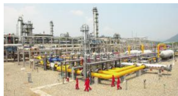
普光气田集气总站 钟建堂/摄
