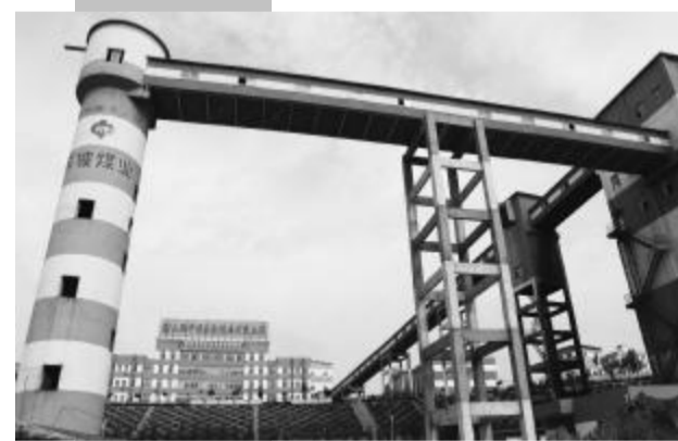
东坡煤电循环工业园区
