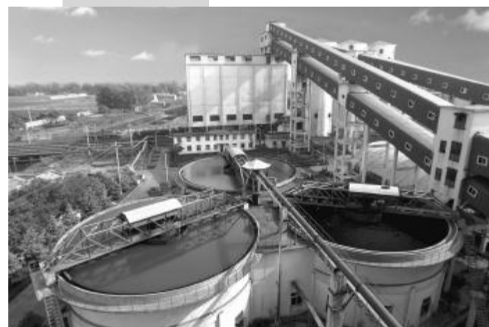
永煤集团现代化选煤厂场景
