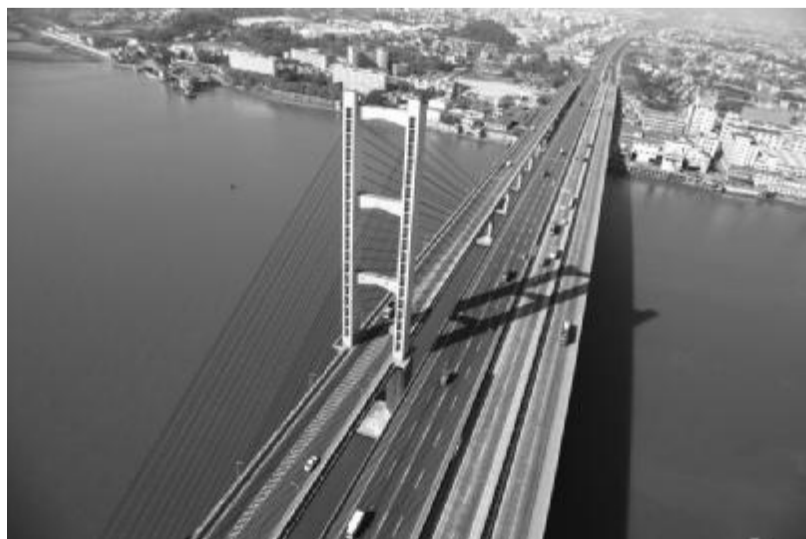
扩建后的佛开高速公路九江大桥
