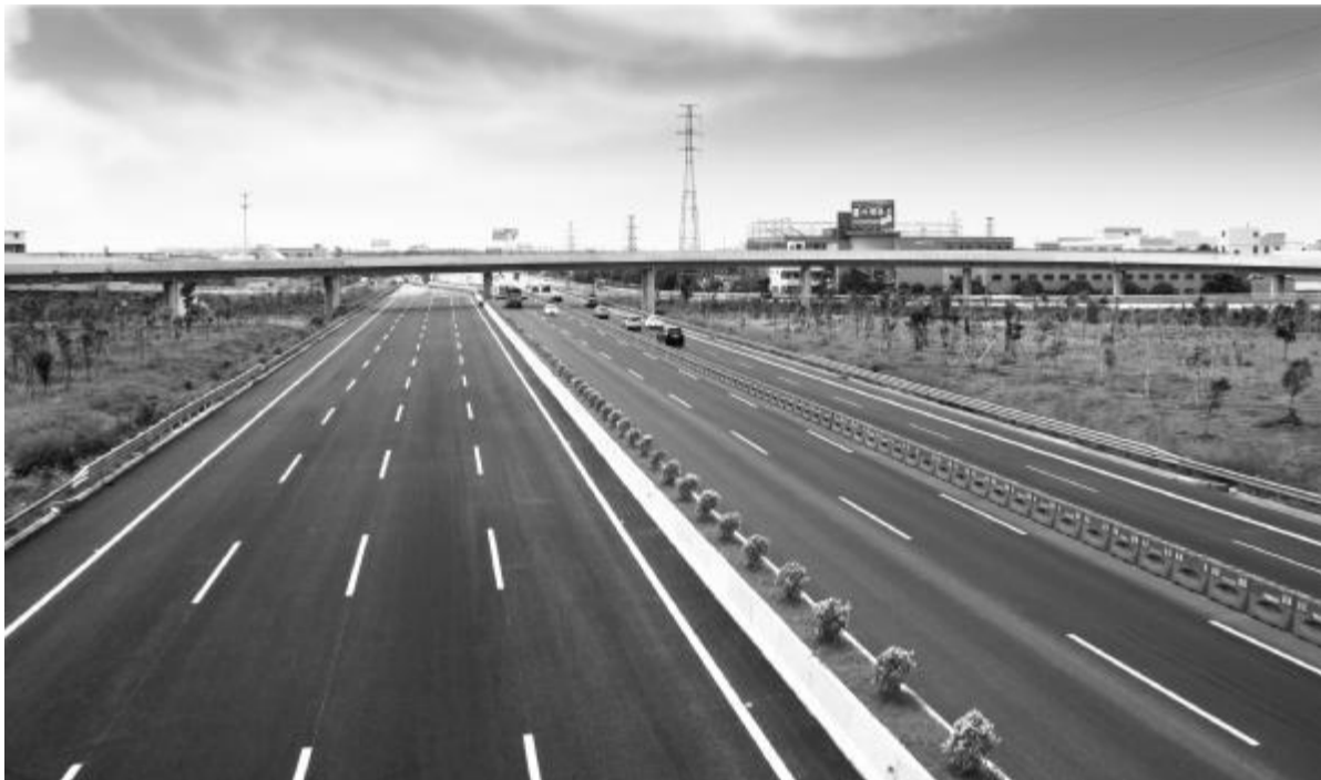
施工过程中的佛开扩建项目
