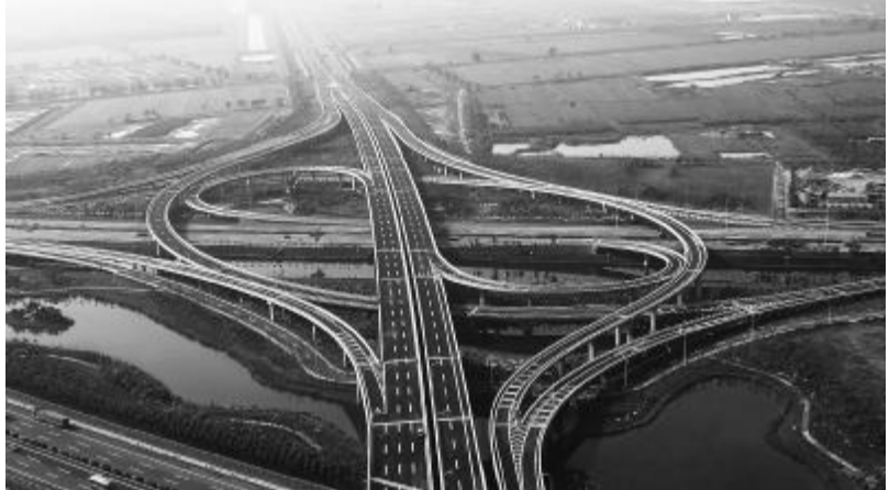
滨海国际机场大道立交桥
