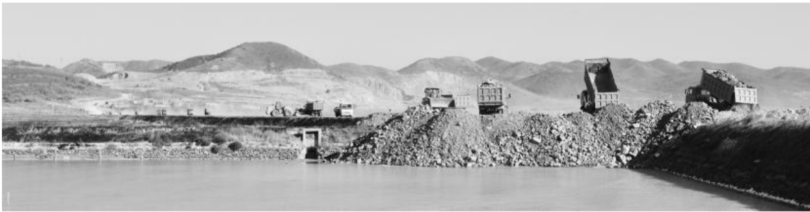
大连太平湾临港经济区建设工程现场
