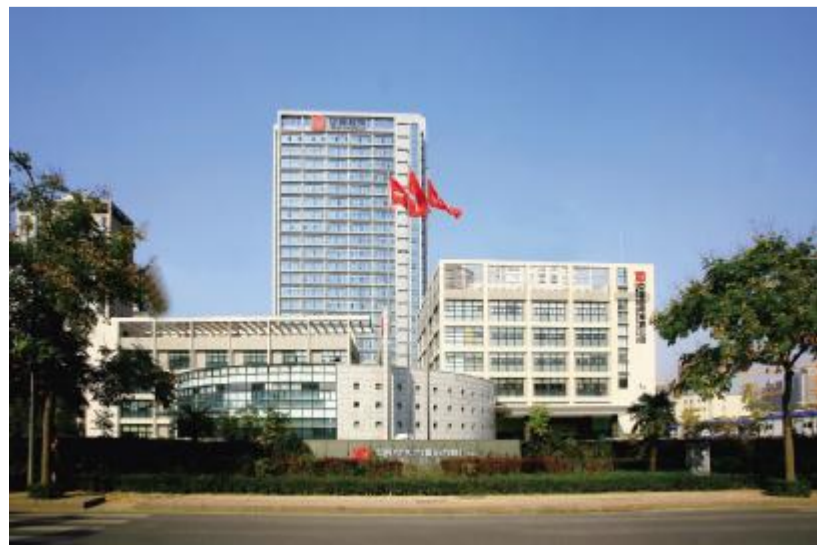
位于西安市高新区的中国西电集团公司总部大楼外景
