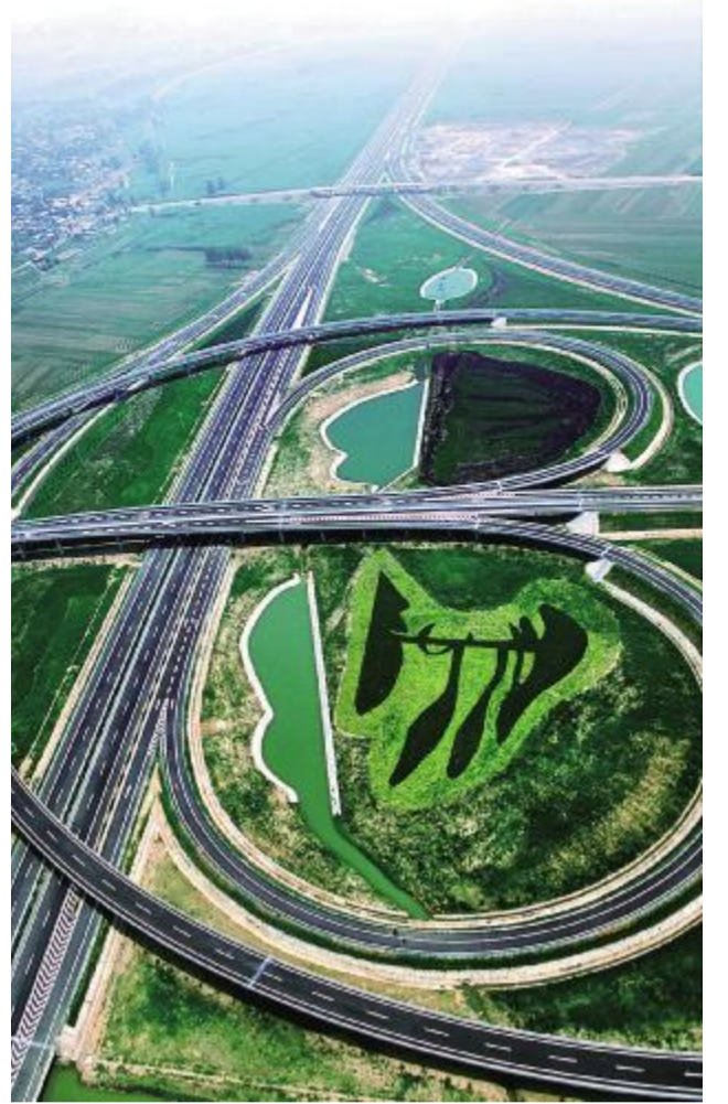
集团施工的连霍高速景观绿化工程
