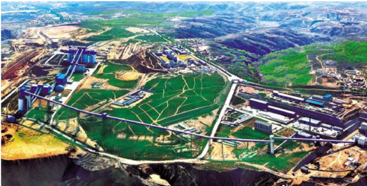
集团施工的内蒙古蒙泰不连沟矿井及选煤厂
