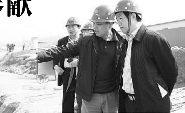
郝文朝经理(中)陪同上级领导视察施工现场
