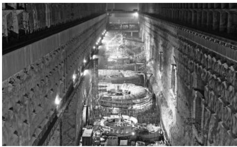
溪洛渡右岸地下电站厂房施工场 李景寿/摄
