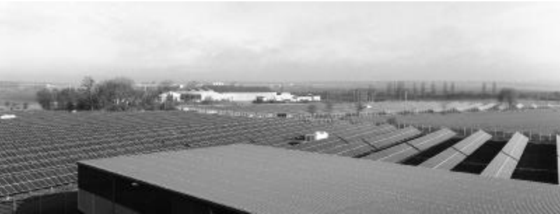
中盛光电集团德国Oberroblingen光伏电站项目
