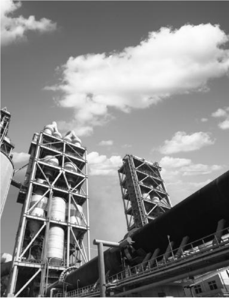
中国建材日产 6000 吨水泥熟料生产线
