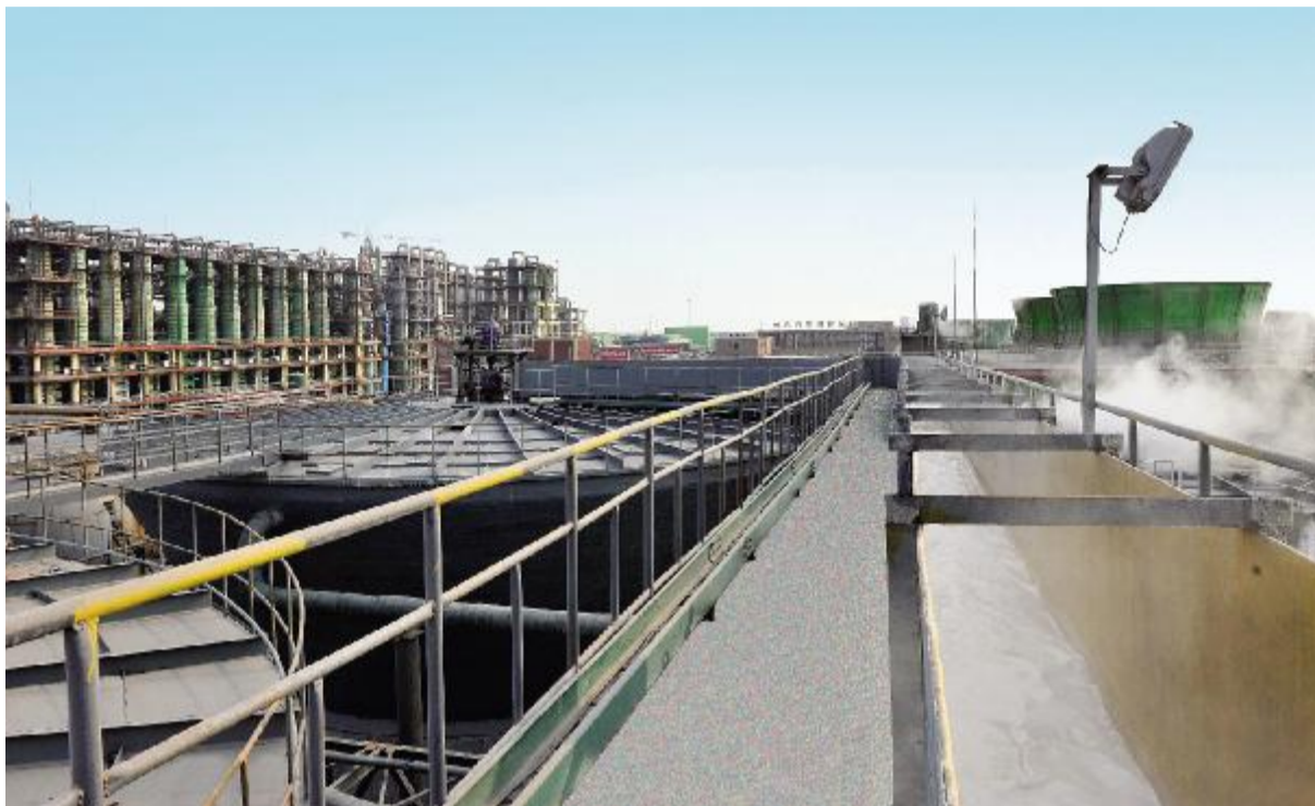
三友集团浓海水综合利用项目建成投产
