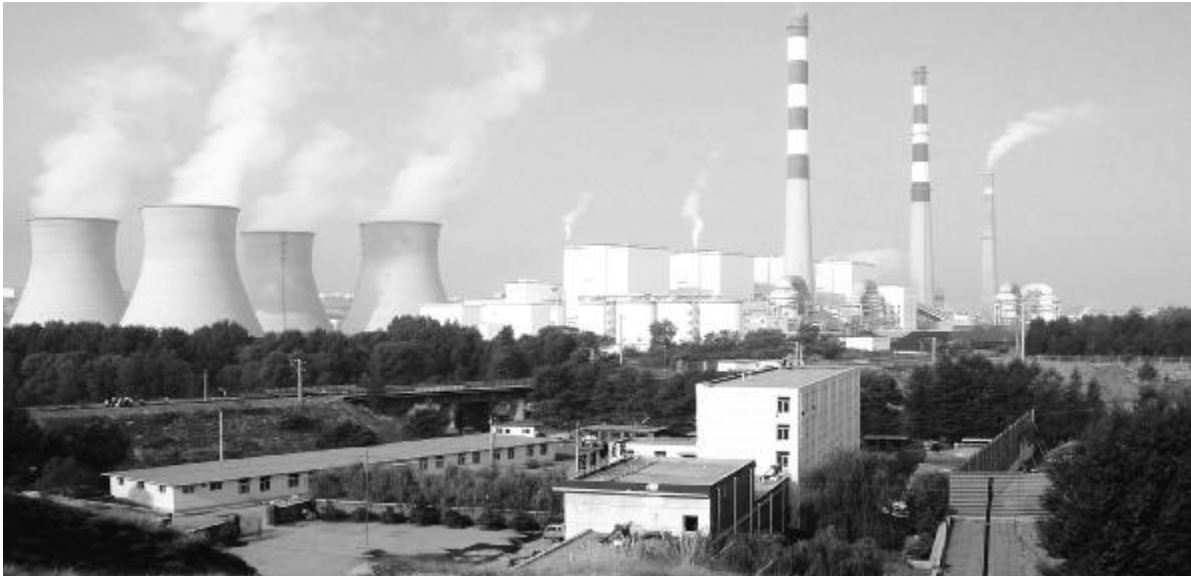
冀中能源煤电一体化
