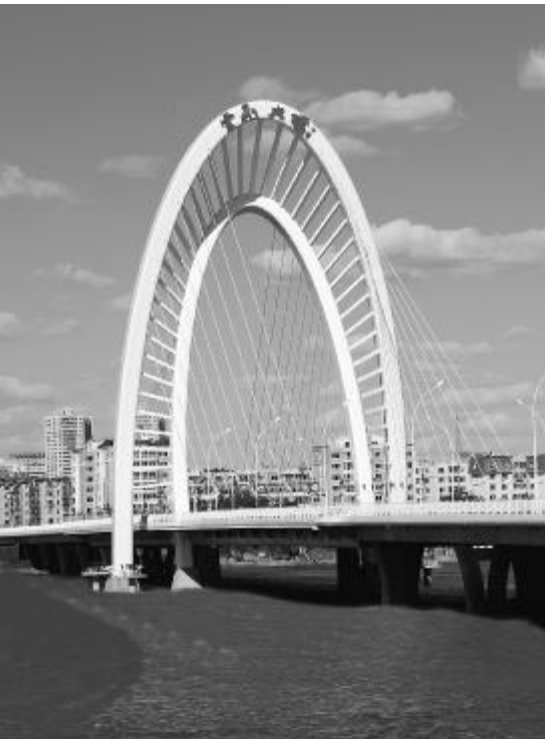
天津城建集团承建的锦州小凌河大桥
