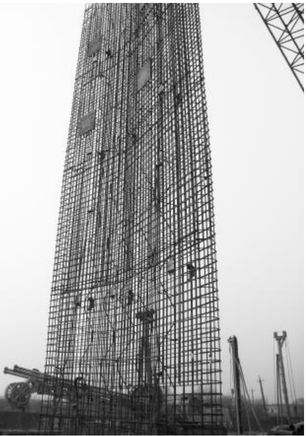
明挖隧道地连墙钢筋笼吊装
