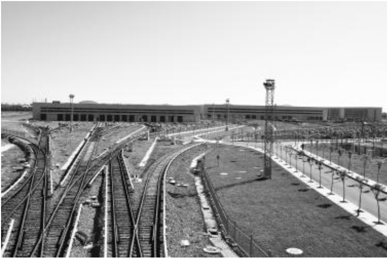
运用库、检修库及站场全景
