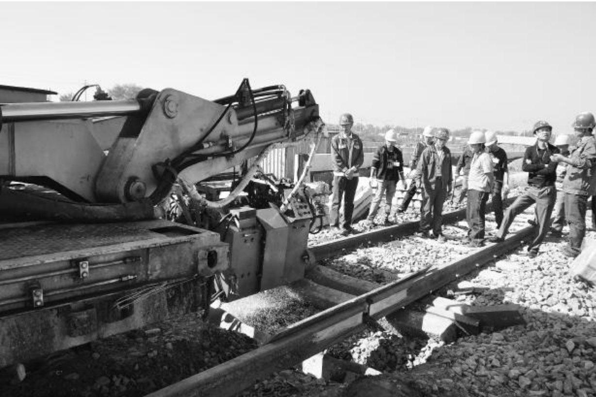
轨排接头焊接
