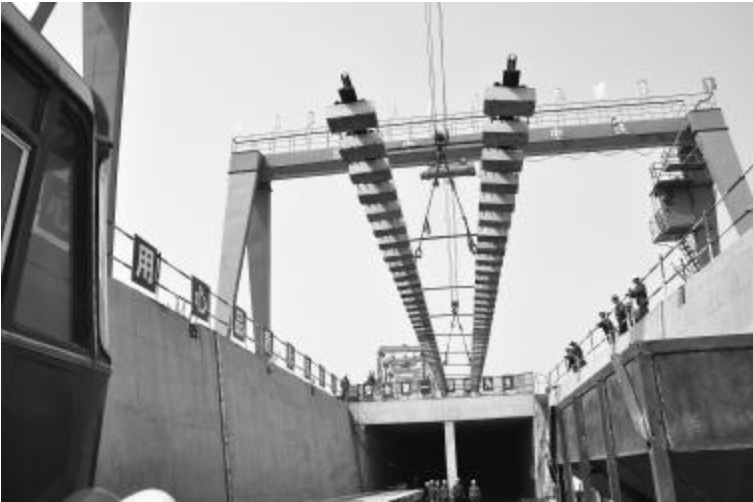
第一组轨排正式下线
