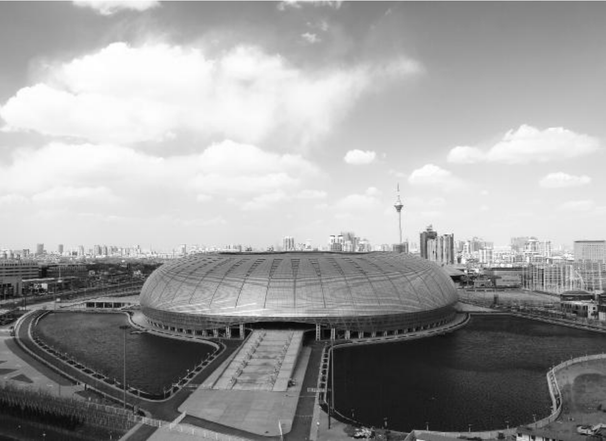
奥林匹克中心体育场项目桩基工程荣获国家优质工程“鲁班奖”
