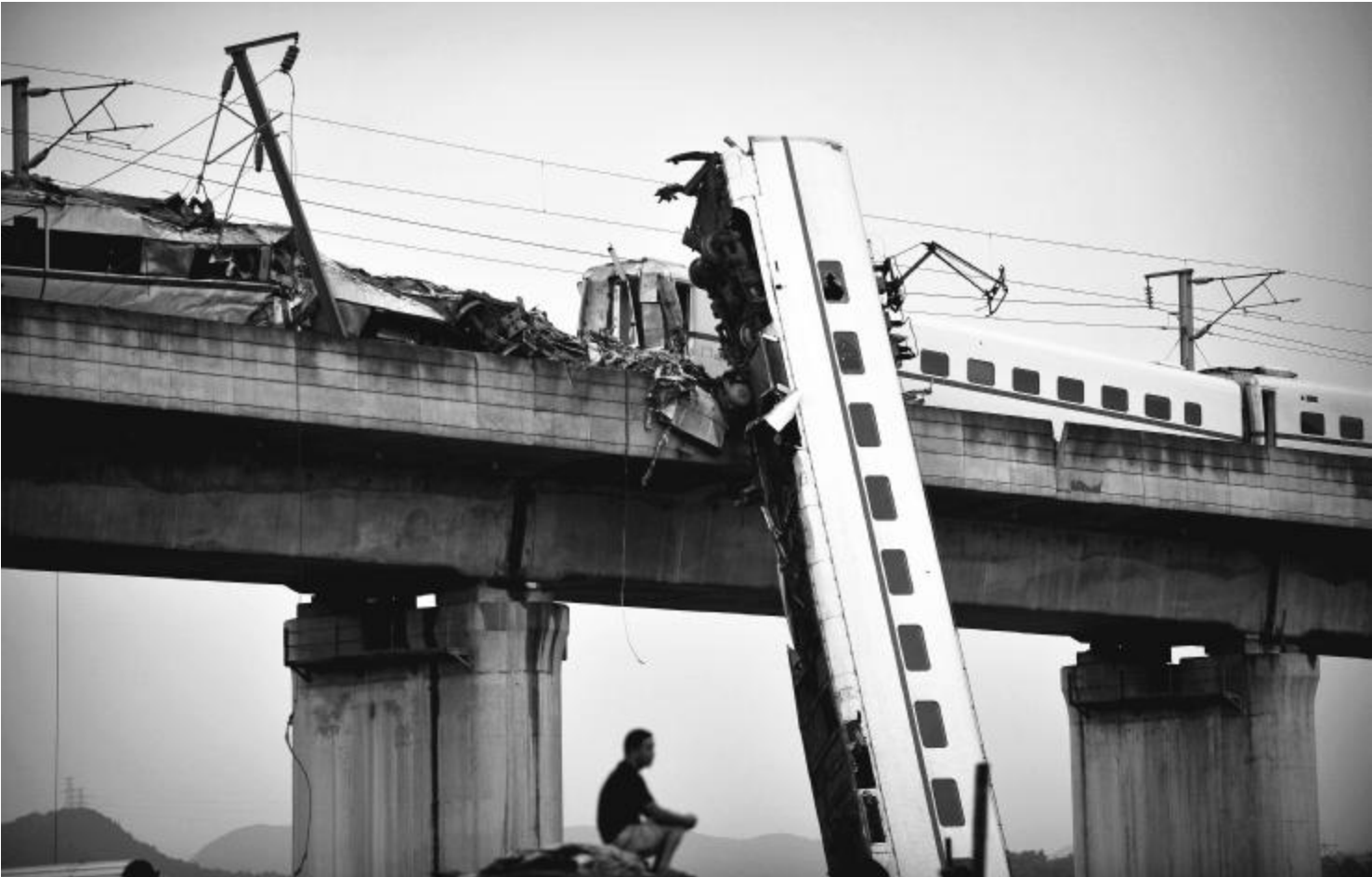
“7·23”甬温线动车特大事故现场惨状 CNS 供图
