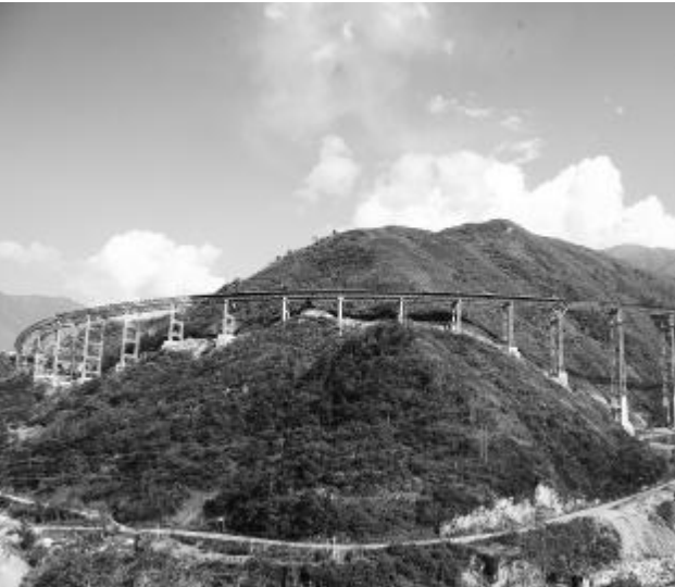
二十三局集团承建的交通运输部重点科研工程、世界第一钢管桁架梁桥—雅泸高速公路干海子特大桥。最高格构墩 110 米,最长一联 999.6 米,最大跨径 62.5 米,第一次采用钢纤维钢管混凝土桥面,多项指标为世界之最。
