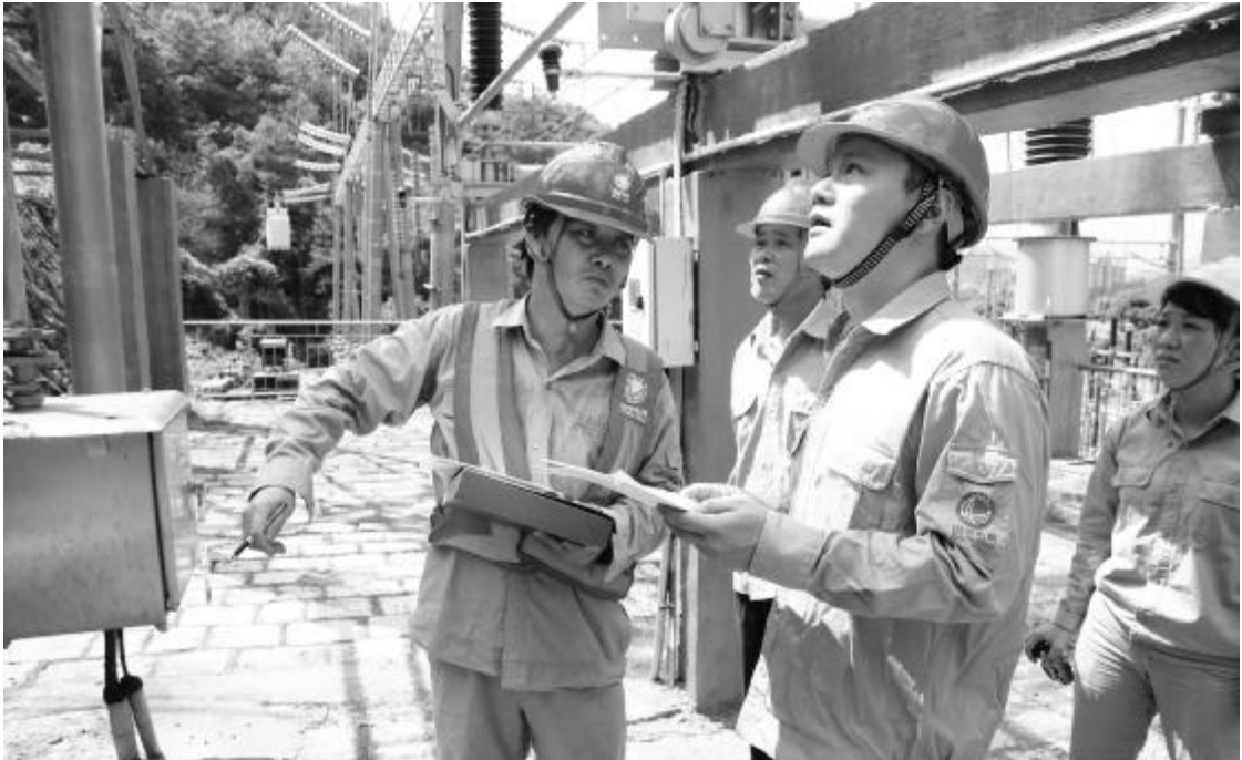
吴跃斌局长深入电网建设施工现场检查
