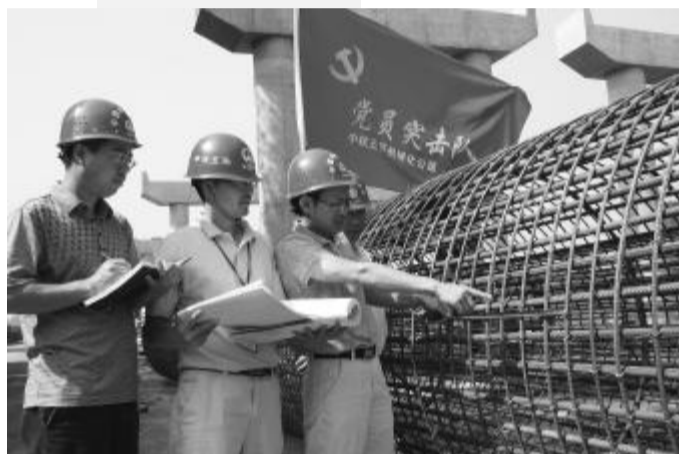
项目部党员质检小组检查钢筋笼质量
