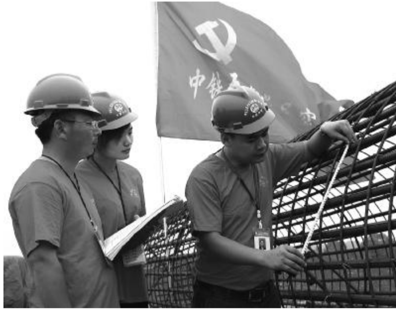
项目经理张程(右一)检查钢筋笼质量
