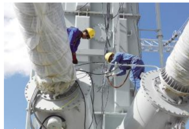
服务人员现场精心安装
