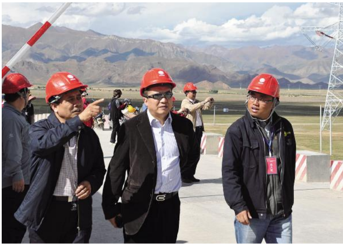
西电集团总经理张雅林在青藏线施工现场调研
