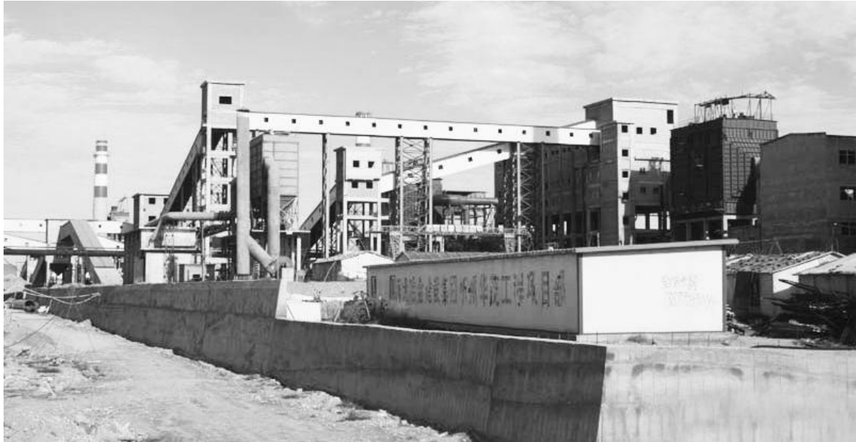
建设中的华茂投资项目
