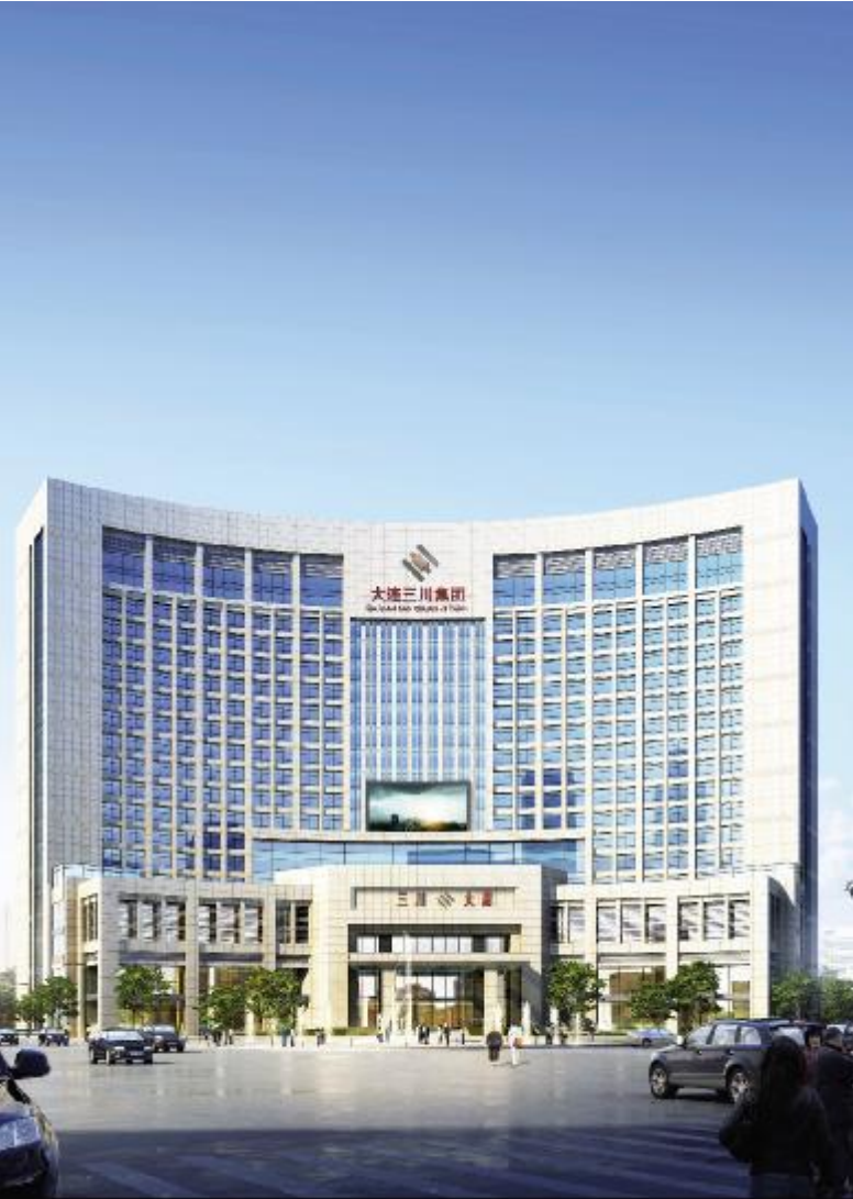
建设中的三川大厦
