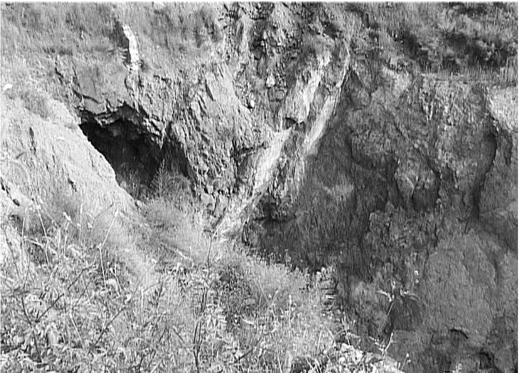
河北省迁西县峪门铁矿相关人士指称,姜永龙为了挖铁矿石形成了深达近30米的大坑,不但阻断了河道,也使原来的路改道而行。现在的道路非常狭窄且坑边没有任何保护措施,下雨路滑时极易发生事故。本报记者 郝帅摄
