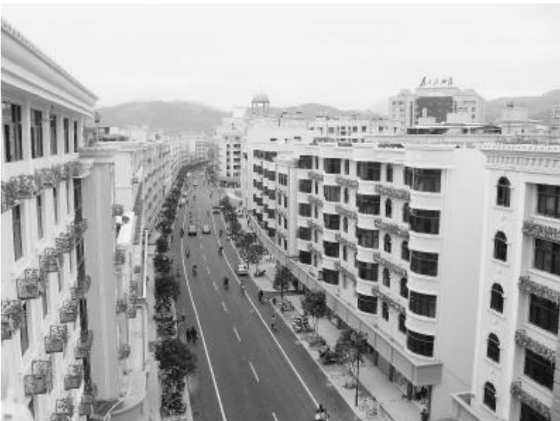
改造后的永春县 823 东路。
