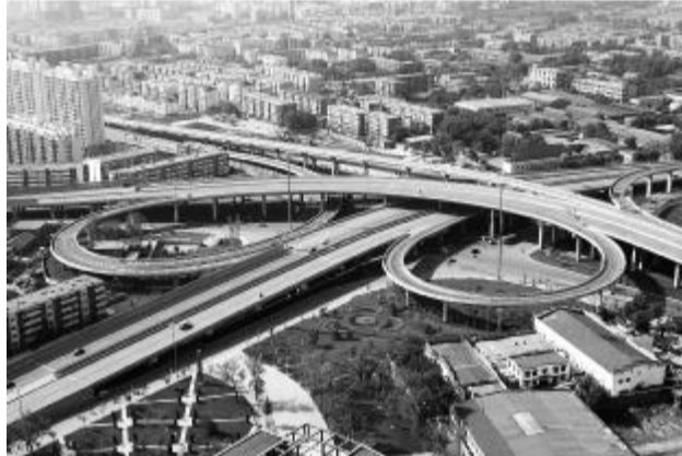
荣获鲁班奖的顺驰立交桥项目
