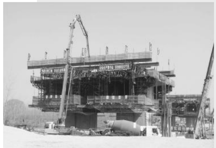
该公司承建现浇变截面预应力混凝土连续箱梁施工现场
