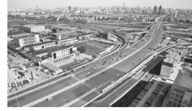
富康路立交工程
