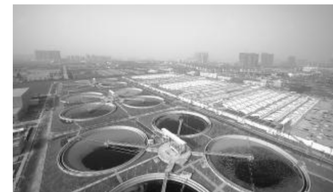
杭州七格污水处理厂
