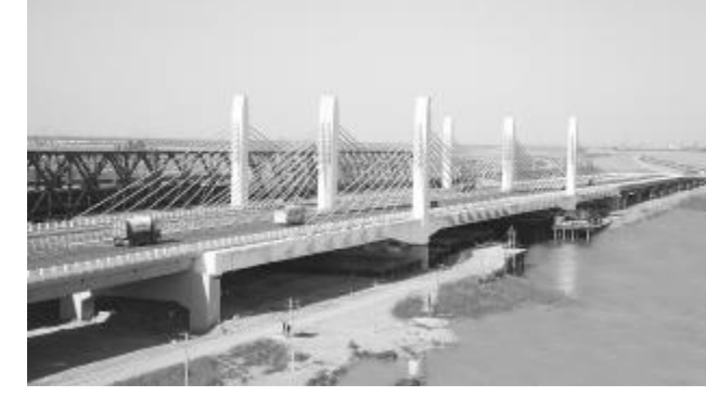
塘汉快速路永定新河特大桥
